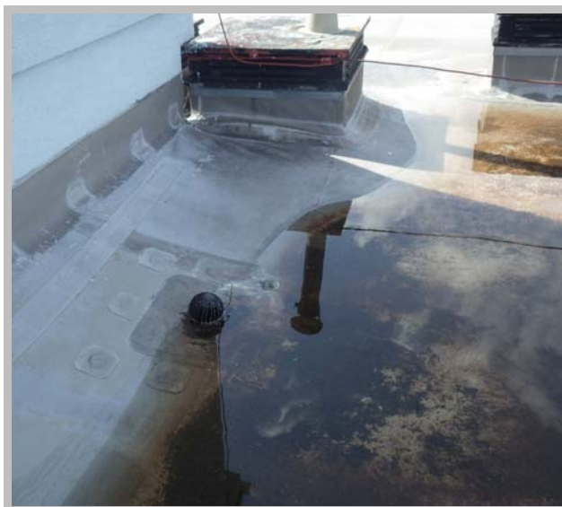
Obr. č 22 a 23 (nedostatečné spádování, stav vpustí):
