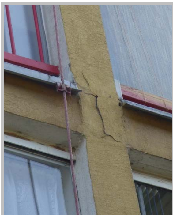
Obr. č 7 a 8 (nevhodně řešené detaily – nevhodné řešení křížového styku panelu / utopený ocelový profil zábradlí):
