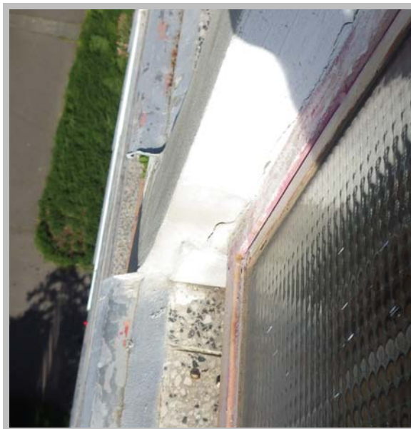
Obr. č 17 (odpadávání omítkových vrstev podhledů a čílek lodžii):
