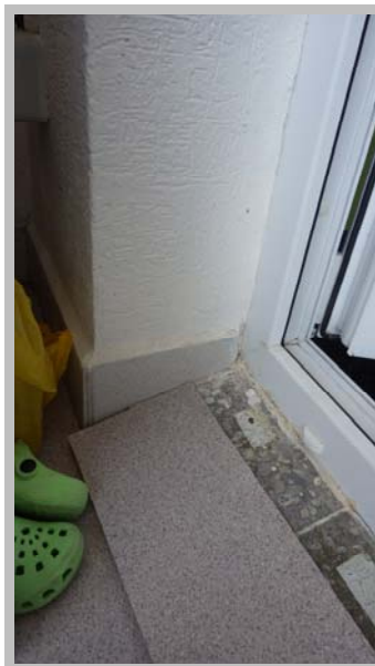
Obr. č 15 a 16 (detaily u lodžii – koroze zábradlí / netěsný detail napojení lodžiových dveří):
