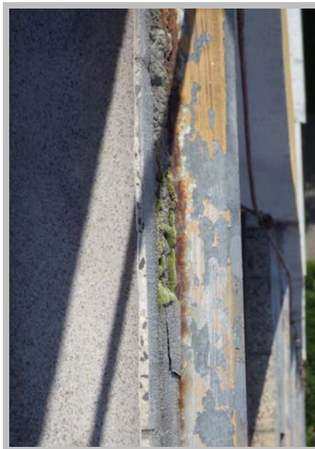
Obr. č 15 a 16 (detaily u lodžii – koroze zábradlí / netěsný detail napojení lodžiových dveří):
