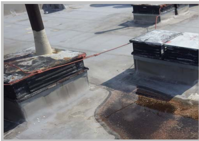
Obr. č 22 a 23 (nedostatečné spádování, stav vpustí):
