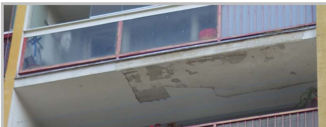
Obr. č 17 (odpadávání omítkových vrstev podhledů a čílek lodžii):
